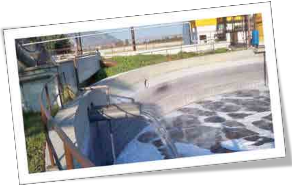
Söktaş Tekstil Atık Su Arıtma Tesisi
